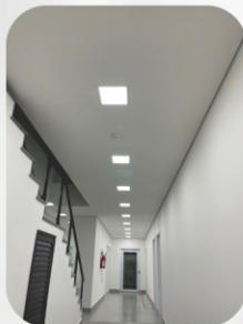
Forro em Drywall
